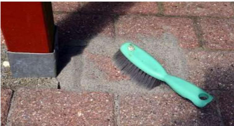
Dazu auf der trockenen Fläche die Fugen mit trockenem Material auffüllen und mit einer Rüttelplatte oder mit einem Gummihammer gleichmäßig und vollständig verdichten.
